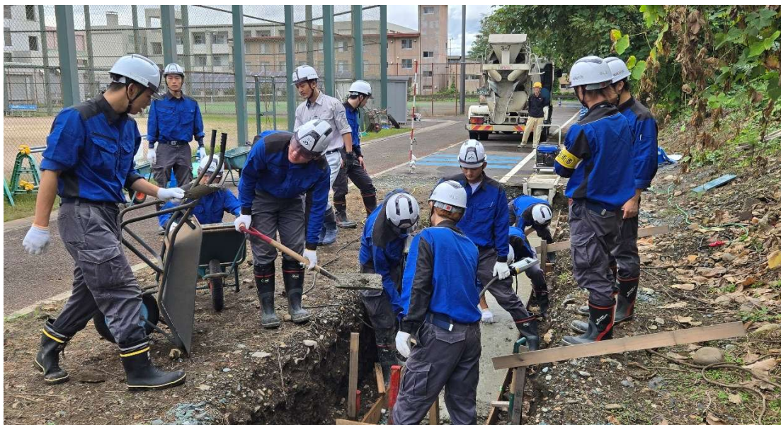
施工管理実習（側溝敷設工事）
