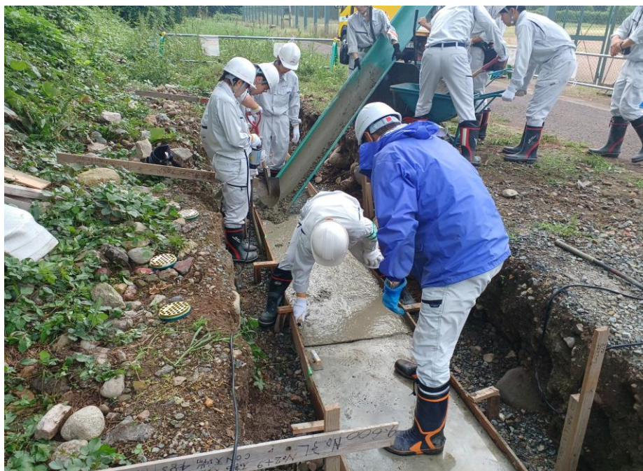
施工管理実習（側溝敷設工事）
